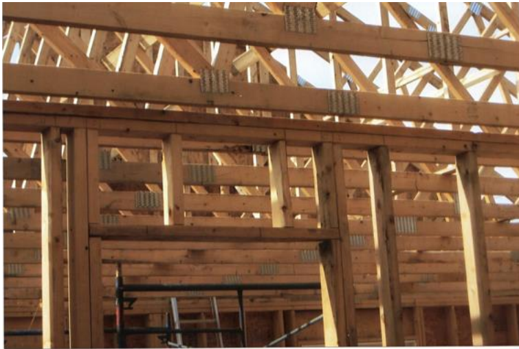
Cloisons intérieures non soutenues. Des tasseaux doivent être ajoutés avant la fixation des cloisons intérieures.
